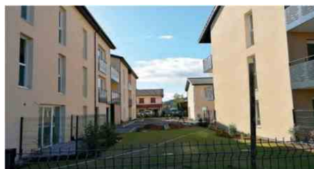
Les finitions sont en cours.
