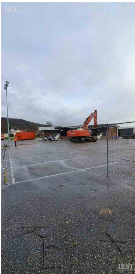
La démolition a débuté ce lundi 15 mars. Photo ER
