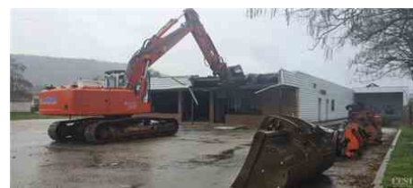
Le site accueillera un immeuble de 48 logements. Photo ER
