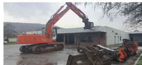
La démolition a débuté ce lundi 15 mars Photo ER
