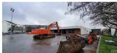
En friche depuis 2015, le bâtiment de l'ancien magasin fait l'objet d'opérations de destruction. Photo ER
