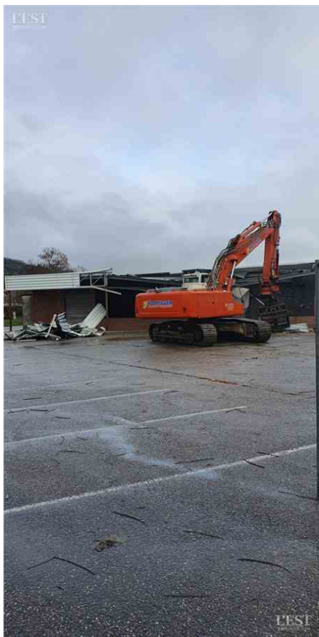
Tous les éléments de construction font l'objet d'un tri minutieux afin de les valoriser Photo ER
