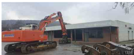
Les premiers coups de pelle ont marqué le début de la destruction du bâtiment.
