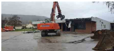
Lors de la destruction, chaque matériau est trié Photo ER
