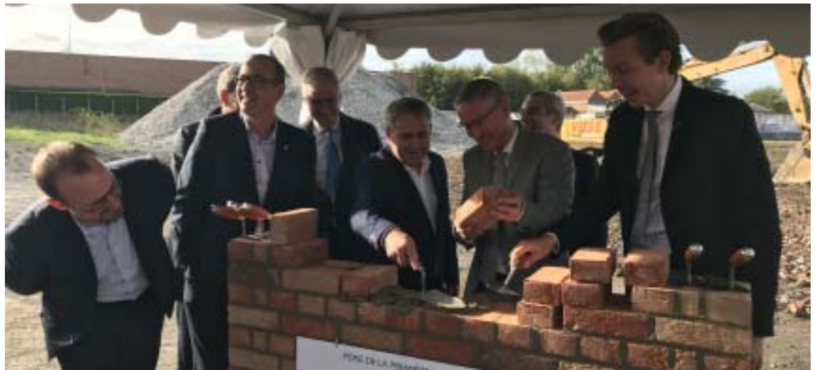
Hier, Gustave Dassonville et Xavier Bertrand ont posé la première pierre d'une opération immobilière qui doit bouleverser le visage du quartier, à l'entrée de la rue de la Lys.
