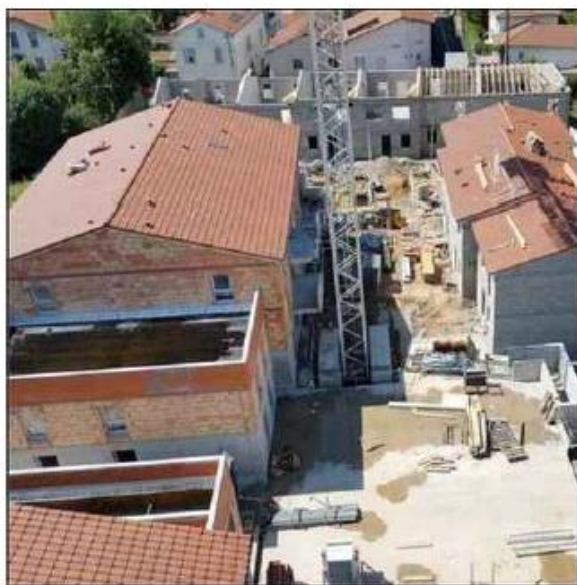
■ Vue aérienne du chantier.
