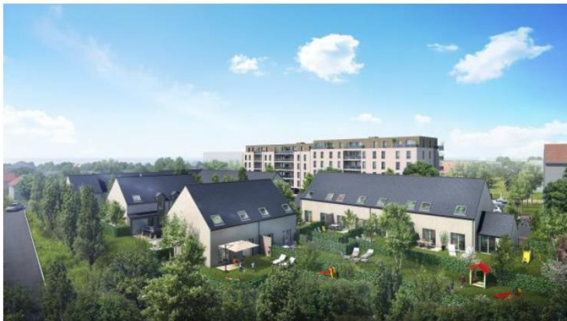
L'ensemble immobilier, entre la rue du Léard et l'avenue Rhin-et-Danube. © DR
